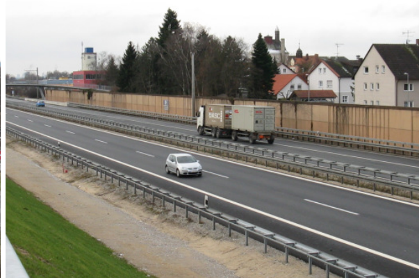
Lärmschutzwand westlich der Autobahn
